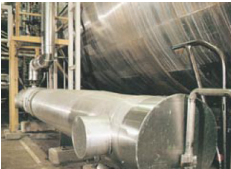
Tjockluts kylare i cellulosa- anläggning
